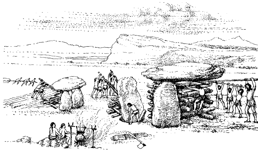
Рис. 1.17. Стовбур дерева був важелем в одному з перших створених людиною допоміжних вантажопідіймних пристроїв
